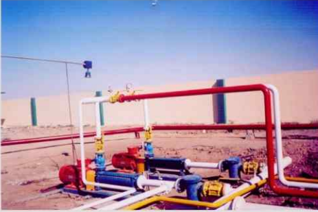
Otogaz İstasyonu Uygulaması Autogas Station Application
