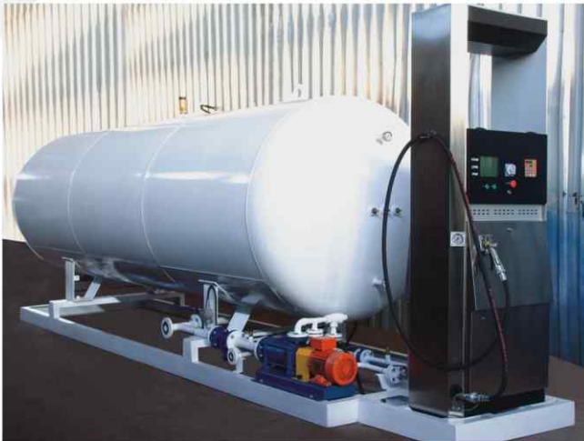
Model No: LPG 50-4 / Taşınabilir LPG İstasyon Uygulaması Model No: LPG 50-4 Skid System Application for LPG
